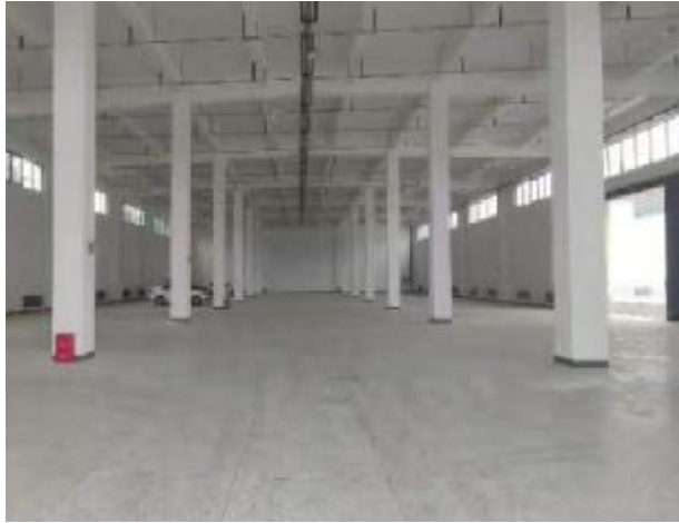
图 3：1#仓库内部情况
